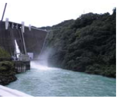
4年宮ヶ瀬ダム
