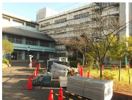
昇降口前の工事の様子
